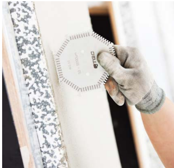
Schichtdickenmessung bei einer Armierung im DAW-Fassadentechnikum
